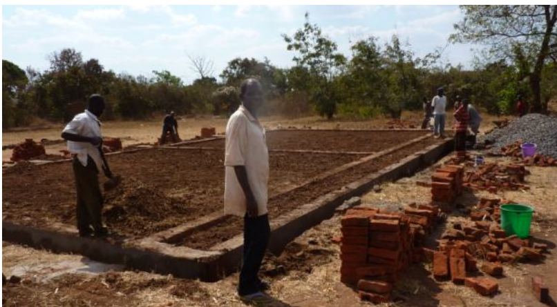
Zwei neue Schulklassen in Waya, bald fertig
